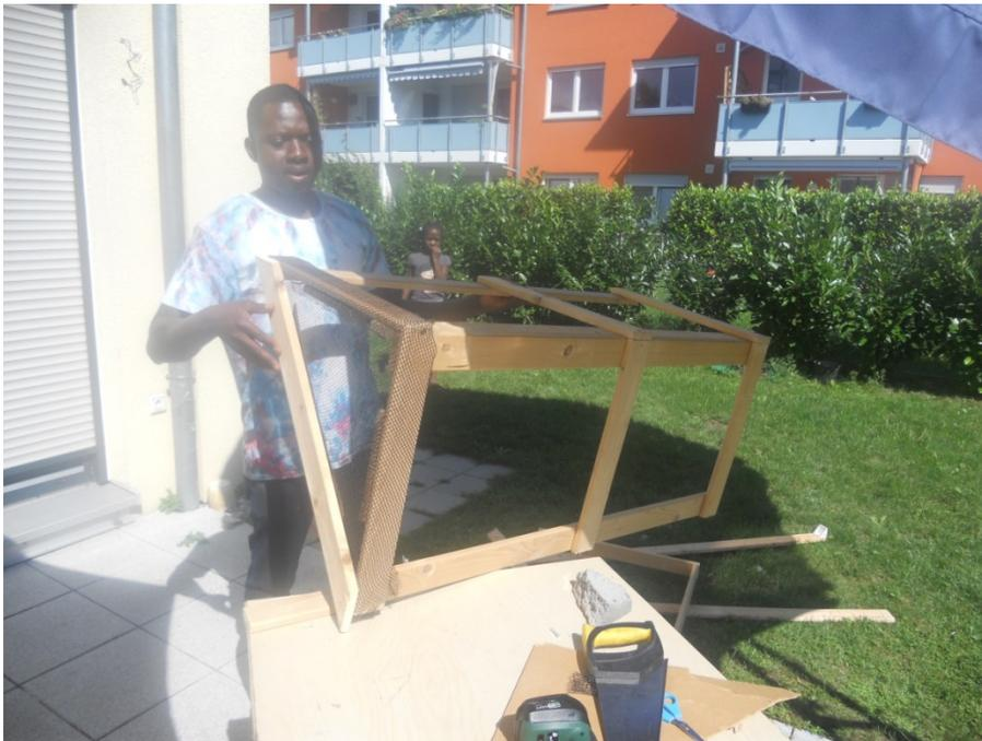
**Photo 12: Pose du filet / grille anti-insecte assurant aussi l'évacuation de l'air sous la toile.**
